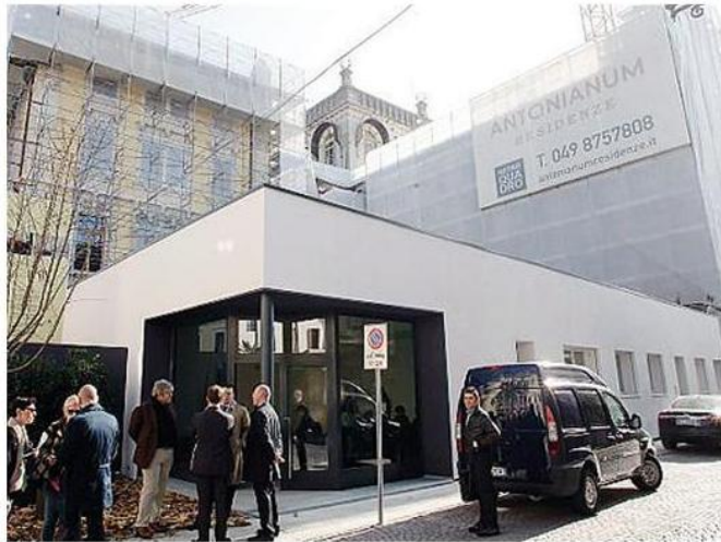
I lavori di ristrutturazione all'ex collegio Antonianum
